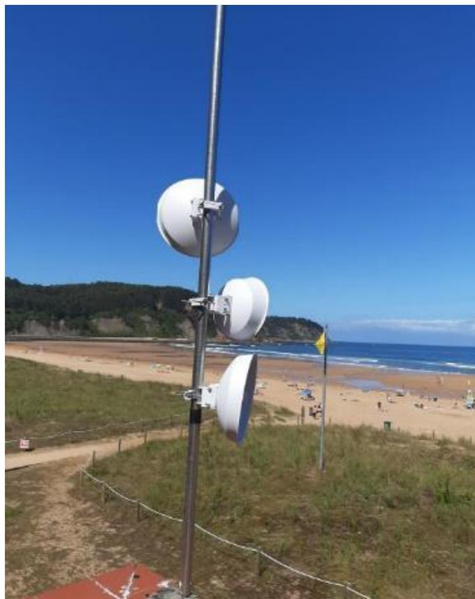
Con el objetivo de dar acceso a banda ancha a diferentes núcleos rurales a los que no llega otro tipo de conexión, el Ayuntamiento de Villaviciosa realizó inversiones encaminadas a contar con una infraestructura de telecomunicaciones para la creación de una red de enlaces inalámbricos sobre frecuencias libres.
